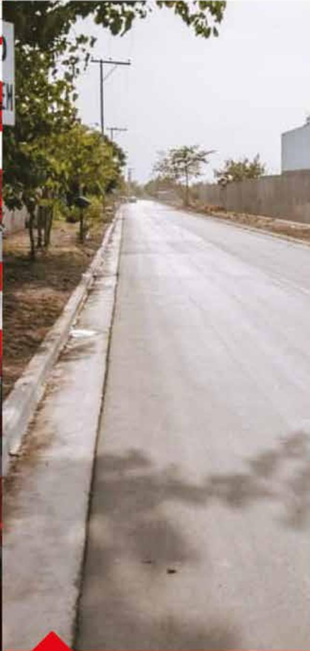
Acceso a Trampa del Tigre. Tipo de obra: pavimentación con carpeta arena -asfalto en caliente.
