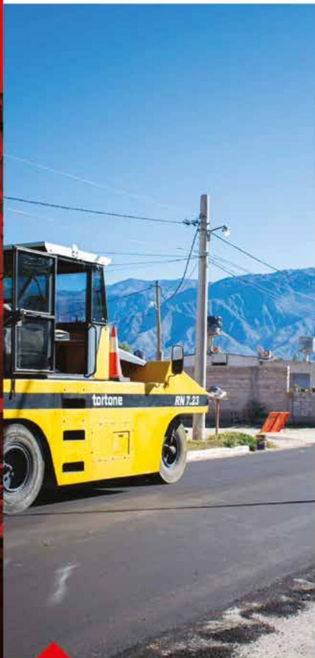
Rotonda acceso a Anillaco, tipo de obra: pavimentación con carpeta arena asfalto en caliente, iluminación y cordones montantes.
