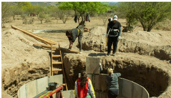
CONSTRUCCIÓN DE CISTERNAS PARA RIEGO
