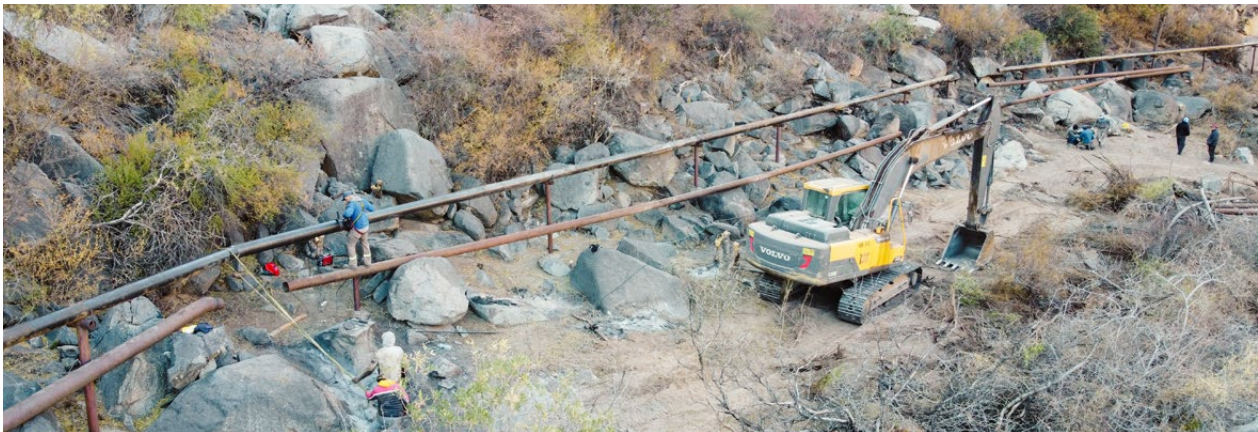
RENOVACIÓN ESTRUCTURAL DE TOMAS DE AGUA - PORTEZUELO
